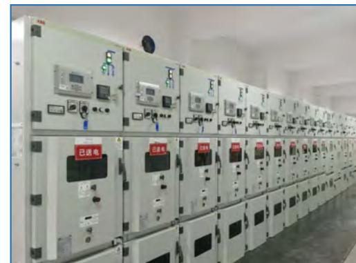
電気電源・計装室は通常、高/低圧配電室、リレー保護室、電池室で構成され、入出力線キュービクル、開閉装置、エネルギー計測キュービクル、屋内変圧器、コンデンサ キュービクル、リレー保護キュービクルなどのさまざまな機器をカバーします。
